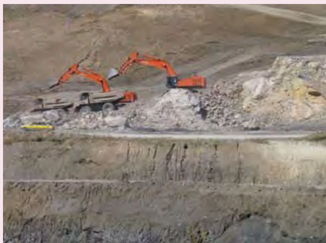
Excavation en rive gauche du barrage de Mahouane.
